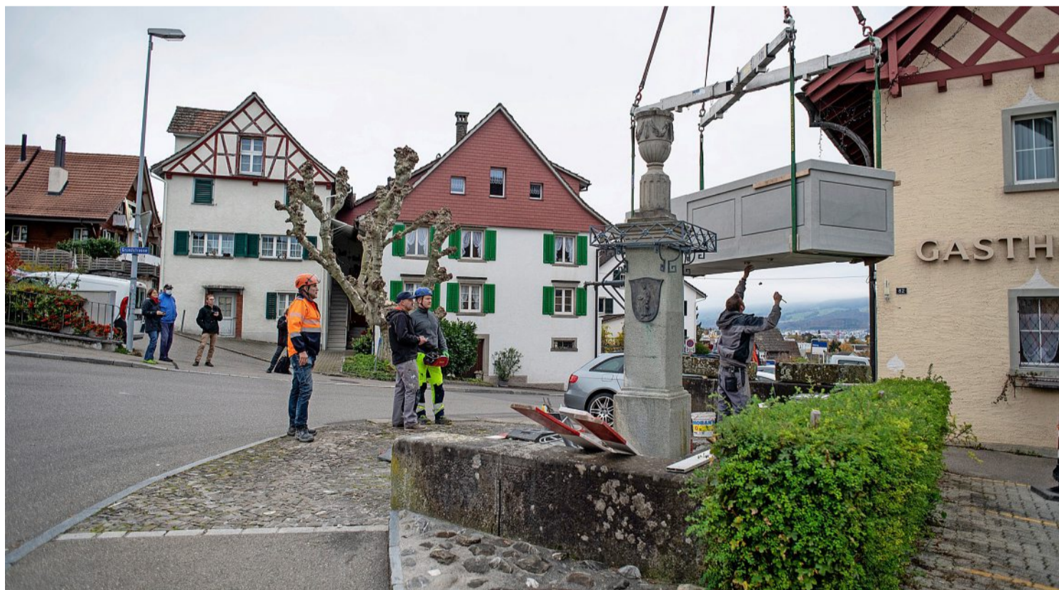
Mit einem Kran wird der neue Brunnen-trog der Brunnengenossenschaft Grundhalden eingesetzt. Foto: Manuela Matt
